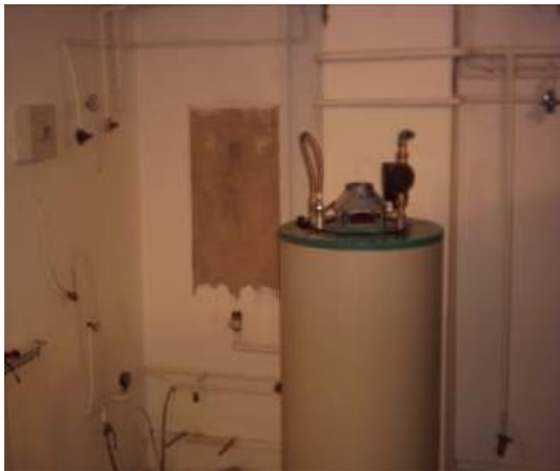
2.sz. kép a meglévő berendezések bontása
