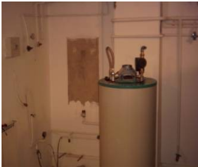
2.sz. kép a meglévő berendezések bontása
