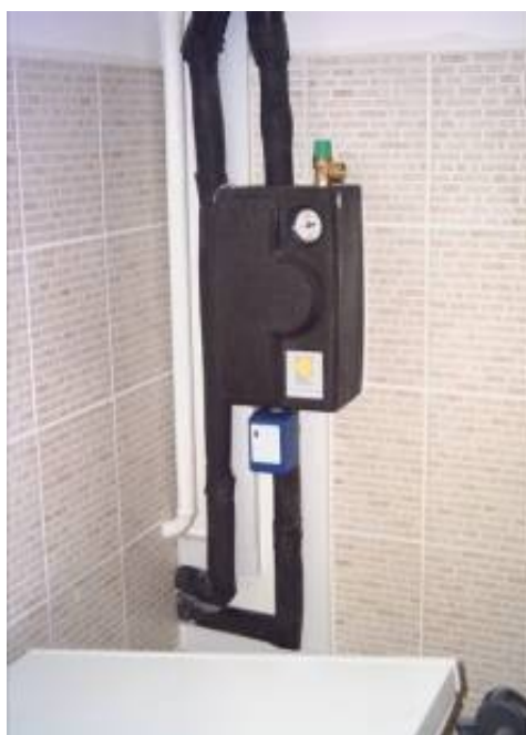
7.sz.kép Solar hidraulikai egység
