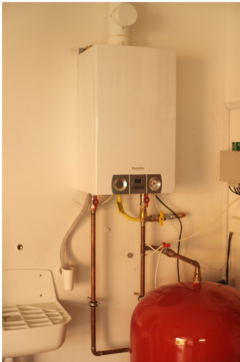
A Paradigma ModuStar S Solo 24 kW-os kondenzációs gázkazán /4.sz. kép/
