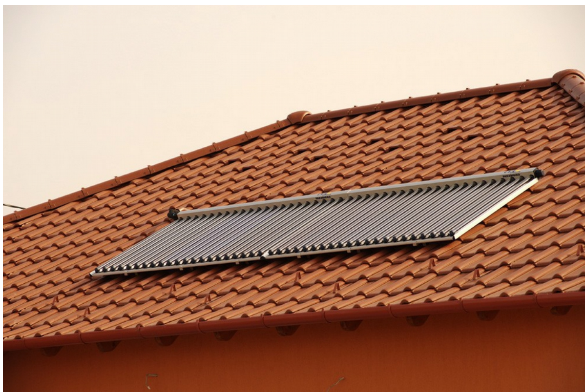
A 2 db CPC 21 Star Azzurro kollektor sorolva /3.sz. kép/
