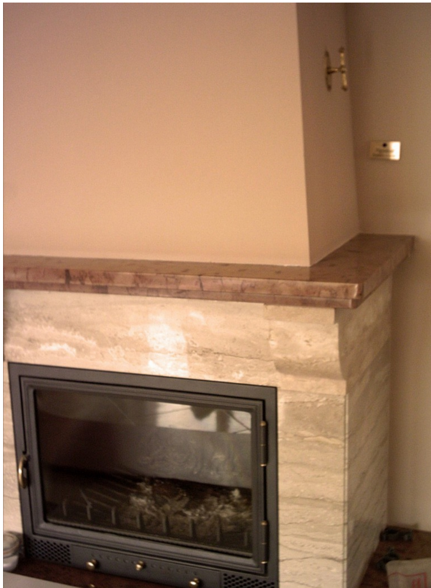
Vízteres kandalló a puffertárolón keresztül a fűtési rendszerbe integrálva /6.sz. kép/
