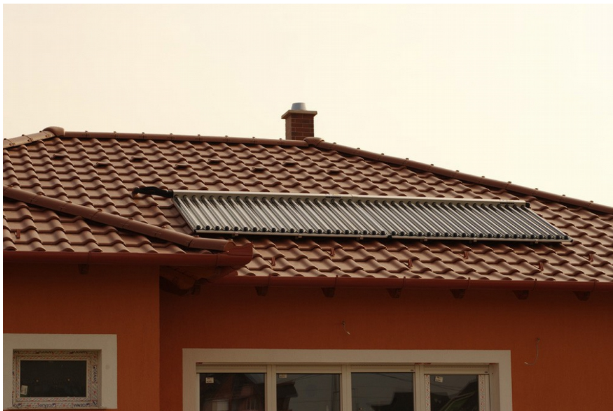
A 2 db CPC 21 Star Azzurro napkollektor sorolva /2.sz. Kép/
