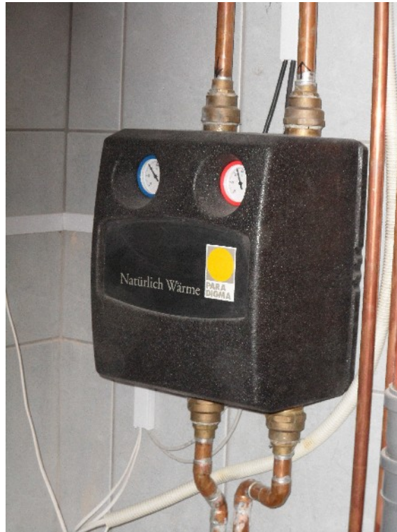
HSM kevert fűtőköri egység /4.sz. kép/
