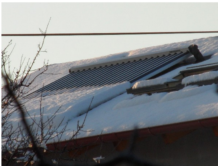
A kerámia bevonatú CPC tükröfelületéről csúszik le a hóréteg /7.sz. kép/
