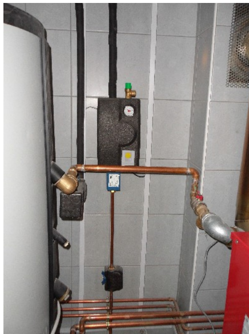
A solar hidraulikai egység /5.sz. kép/
