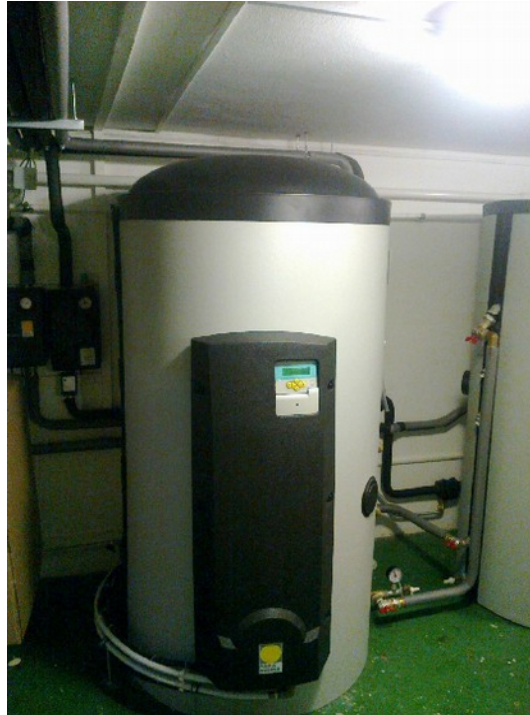
5.sz. kép: Solar hidraulika és a HSM kevert fűtőköri egység
