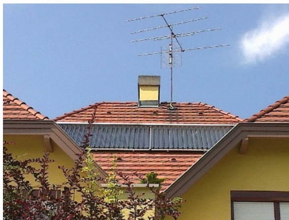
2-3. sz. kép: A nettó 13 m 2 napkollektor felület a tetőn elhelyezve
