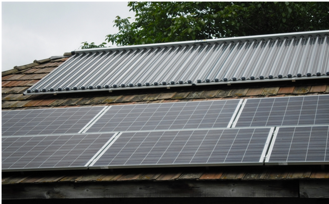
A napkollektor elhelyezkedése a tetőn /részlet 1.sz. kép/
